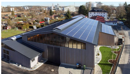
Photovoltaikanlage in Schrobenhausen
