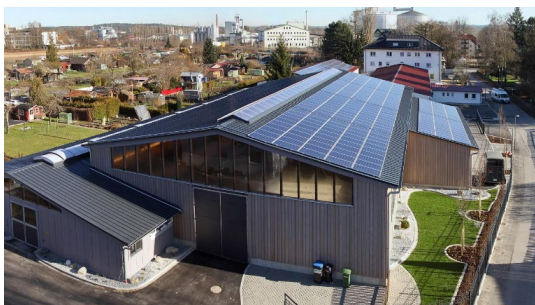
Photovoltaikanlage in Schrobenhausen
